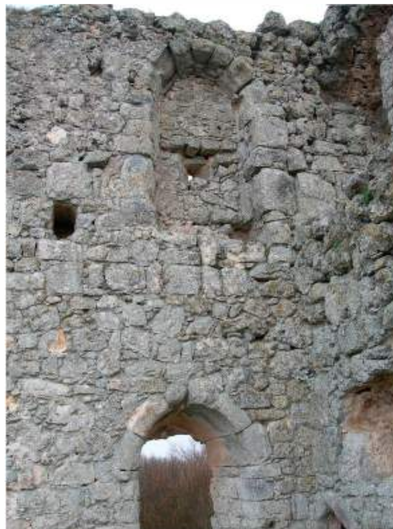
Рис. 390. Внутренняя сторона северо-восточной стены донжона: 1 - дверной проём второго этажа; 2 - оконный проём, превращенный в бойницу (вид с юго-запада)
