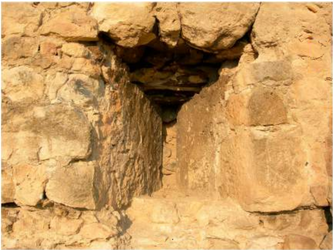
Рис. 213. Щелевидные амбразуры башни №2 крепости Каламита второго строительного периода (1425 - 1433? г.), перекрытые полукруглой башней (четвертый строительный период): 1 - вид на "восточную" амбразуру; 2 - вид изнутри на "западную" амбразуру
