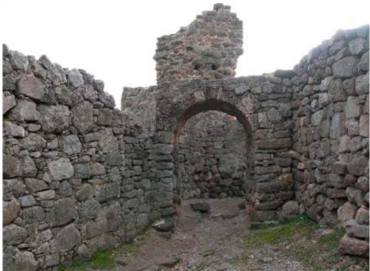
Рис. 206. Цилиндрическая арка ворот крепости Фуна второго строительного периода после реставрации (вид с севера). Фото автора
